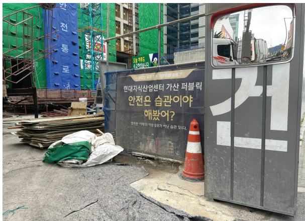
가산디지털단지주변 공사장에 붙은 현수막 ‘안전은 습관이야 해봤어? 안전은 이제 더 이상 업무가 아닌 습관입니다.’
