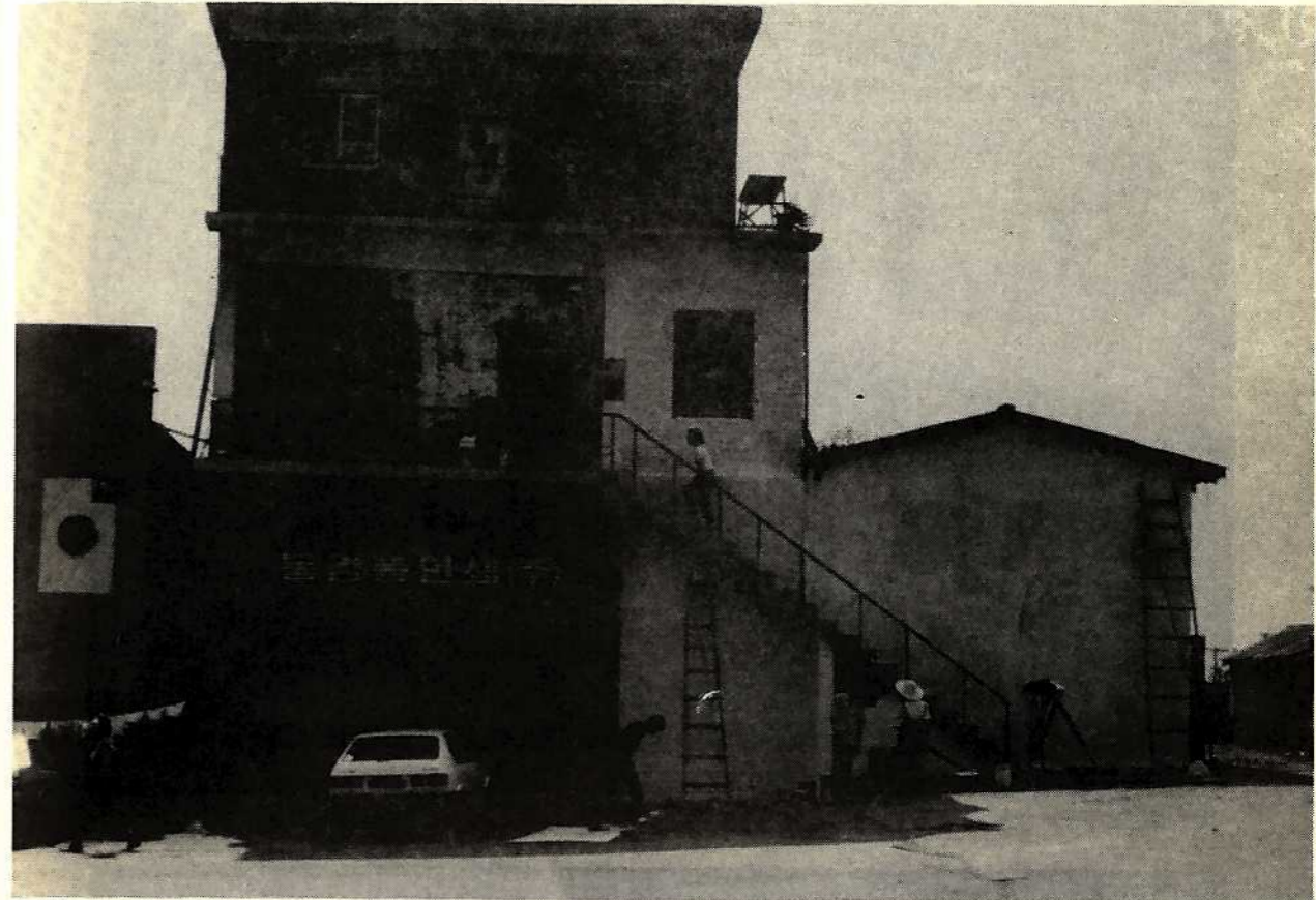
건물벽면에 바락칠하는 모습
