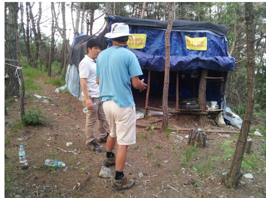
△101번 공사 현장(단장면 태릉리) 현장조사 모습
