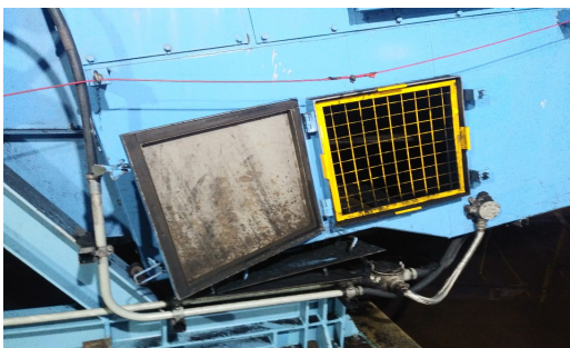
[그림 70] 개구부 안전망 설치
