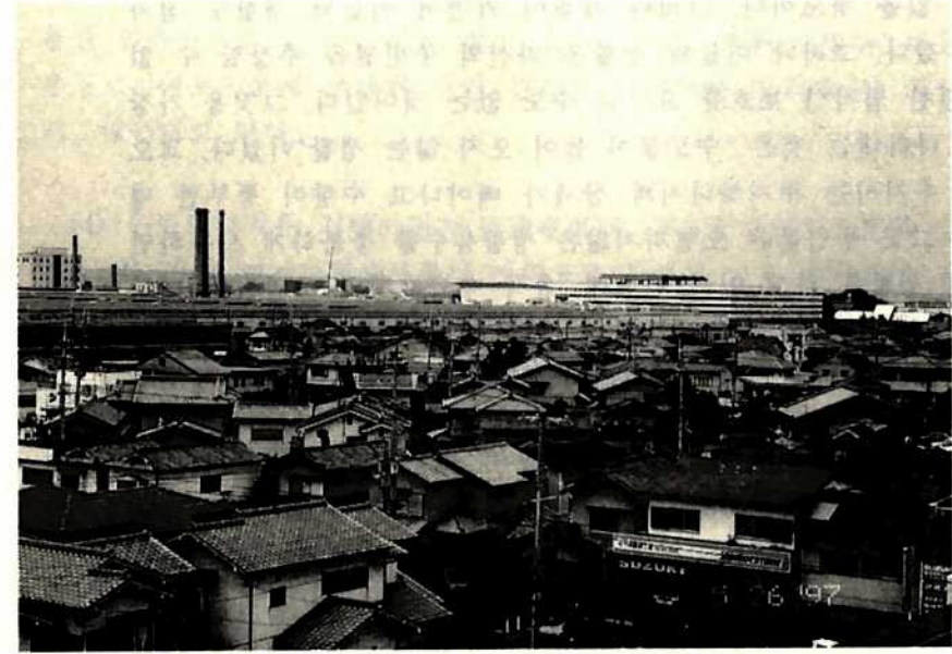
(사진 7, 과거 비행장 부지위에 들어 선 주택가, 멀리 일산차체 건물이 보인다)
