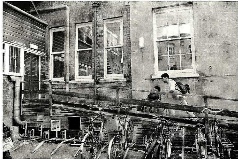
○ 스티븐 호킹박사가 사용하던 건물에 박사를 위해 임시로 설치한 경사로 지금은 호킹박사의 사무실이 신축건물로 이전했다.
