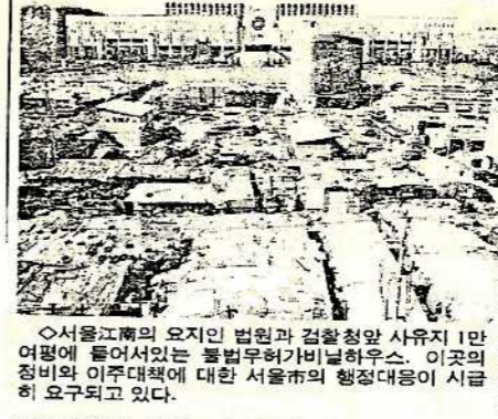
서울시 10여년 동안 대표적 철거 대상지였던 서울 서초구 서초동 법원단지 앞 속칭 '꽃마을'이 24일 전면 철거됐다. 서울 서초구청은 이날 오전 8시경부터 전경 24개 중대 2천8백여명의 지원을 받아 철거반원 1천 2백여명, 포클레인 6대, 운반차량 50대 등의 장비를 투입해 산산조각난 1707㎡의 1만3천여평에 산재한 무허가 가건물촌 3백11개동 2천3백21가구를 10여시간만에 모
