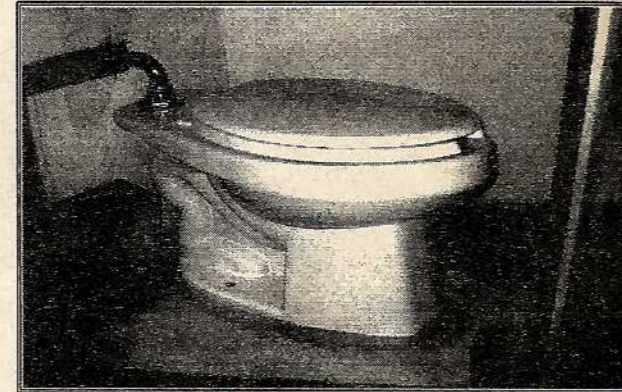
【물탱크 벽속에 시공된 좌변기 모습】
